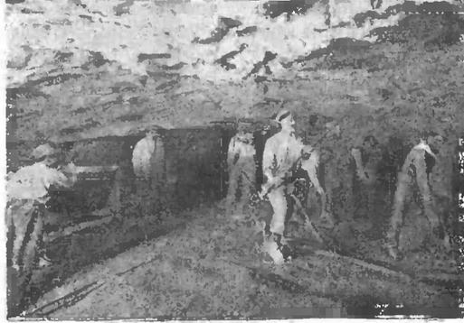
Рис. 8. Работы по расширенію верхней галлерей.
